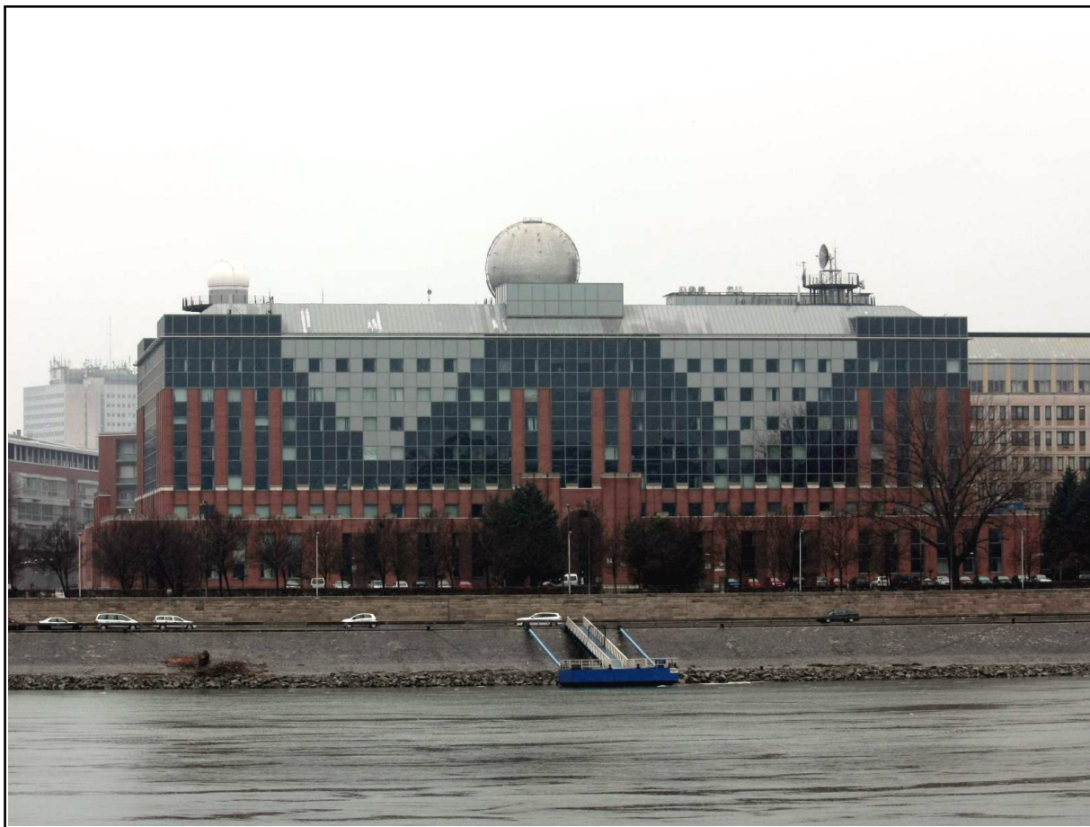
3.2. ábra. Az Eötvös Loránd Tudományegyetem Természettudományi Karának Északi épülete Budapesten. Az épület alsó része vörös téglával, míg a többi része fényes sötétszürke és világosszürke üveglapokkal, valamint ablakokkal borított. A homlokzaton 14, téglával kirakott oszlop is található.
