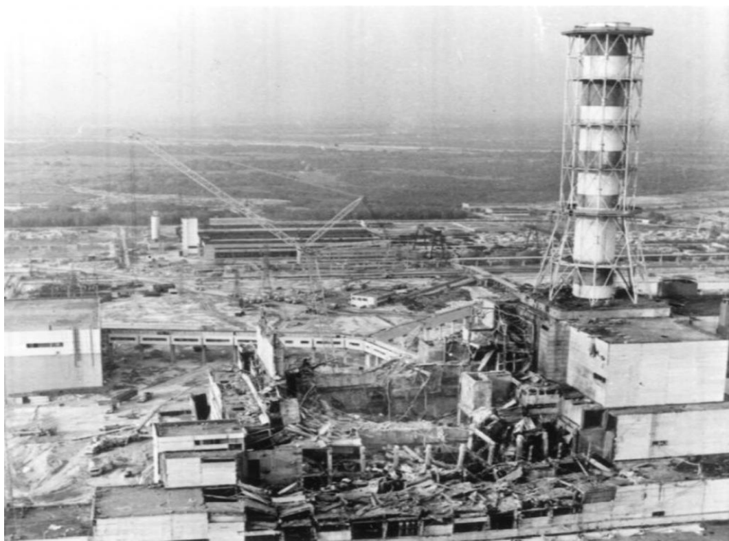
8. ábra. A csernobili reaktor épület a robbanások után [19].
