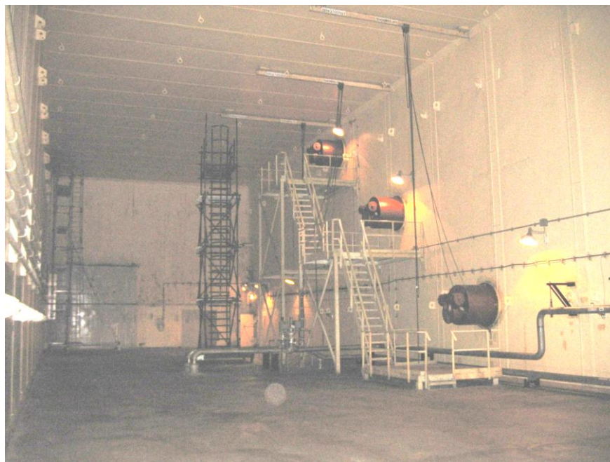
16. ábra. Légsapda a paksi atomerőmű lokalizációs tornyában, látható a három 500 mm-es visszacsapó szelep, amelynek a túloldalán három tálca helyezkedik el [28].
