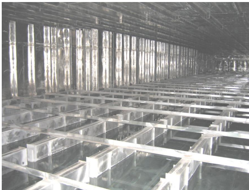
10. ábra. Buborékoltató tálcák a paksi lokalizációs toronyban [28].
