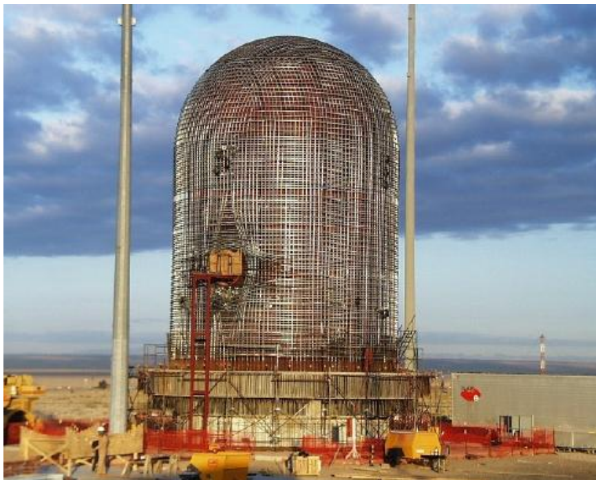
6. ábra. A Sandia laboratórium által épített konténment modell, jól látható a készülő vasbeton szerkezet [26].
