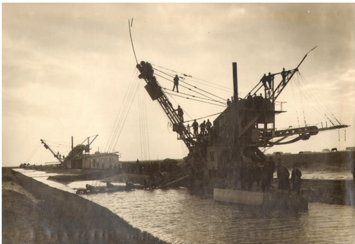
2. ábra. Kotrógépek az épülő csatornánál, Lupkovics Brunó főmérnök felvétele, 1926. Forrás: Duna Múzeum, Történeti Képgyűjtemény, 24.630.
