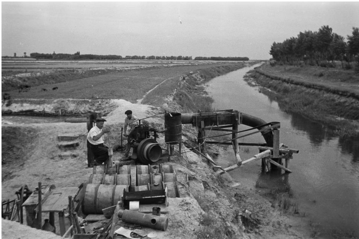
7. ábra. Rizsföldek öntözésére használt szivattyútelep a Duna-völgyi Főcsatorna egy mellékcsatornájánál, Kunszentmiklós, 1949. Forrás: Fortepan, felvétel készítője: M.E. Kovács, Creative Commons CC-BY-SA-3.0 licence.
